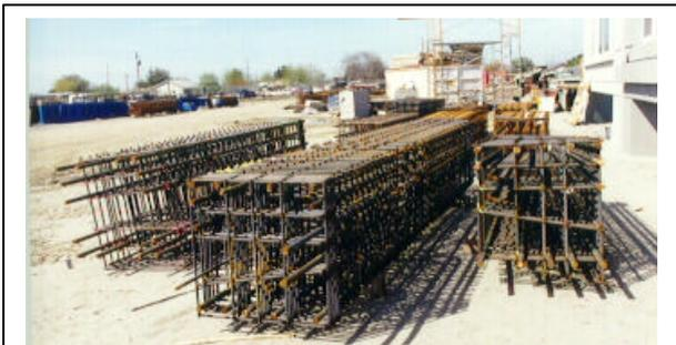
Fig. 19. BauGrids® for Moment Frame Columns
